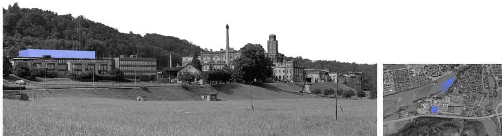
Abbildung 19: Fernwirkung von der Feldschlösschenstrasse bzw. vom Bahnhof, Projekt Hochregallager (farbig markiert)
